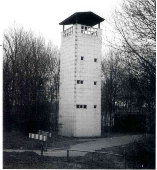
Raatbouwtoeren Ens (Flevoland). Afwijkend van standaardtype door een andere breedte en hoogte, een dichte constructie en het ontbreken van een uitkragende bovenkant. (foto: S. van Lochem)
