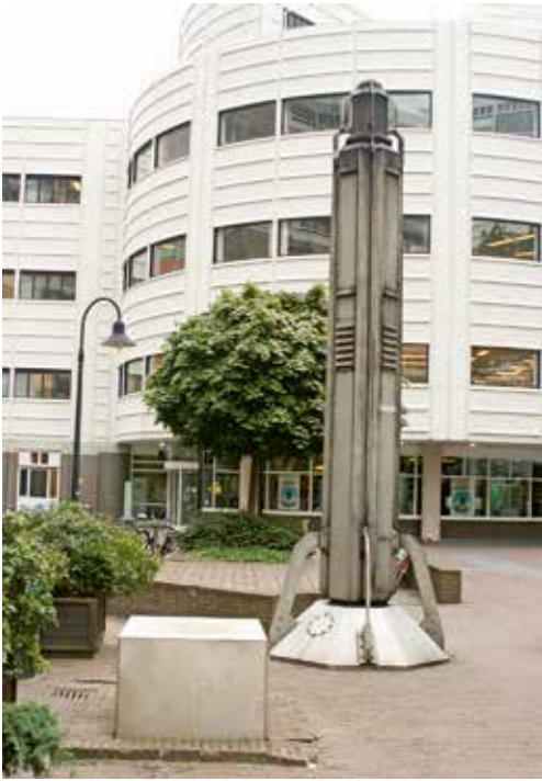
Afb. 8 Hoofdluchtschacht van de noodzetel van het Ministerie van Buitenlandse Zaken aan het Prinses Irene-pad in Den Haag, 2016. Foto: Kees van Leeuwen.
