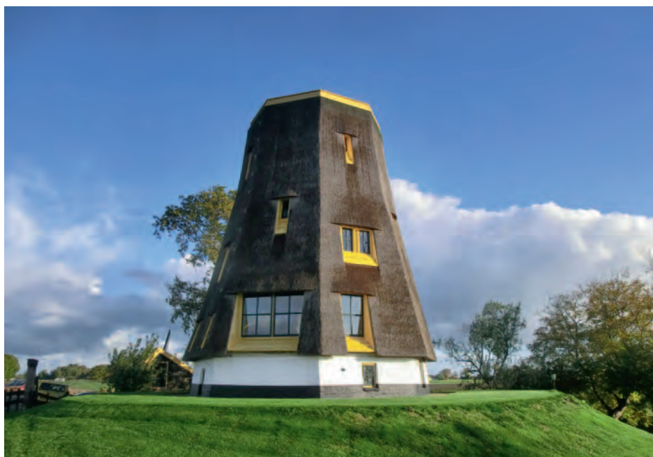
De rietgedekte Molen nr. 6 in Moerkapelle. De (te) grote afstand van de bovenste raampjes tot de bovenkant verraadt de luchtwachtpost die erachter schuil gaat. (Foto: Sandra van Lochem 2016)
